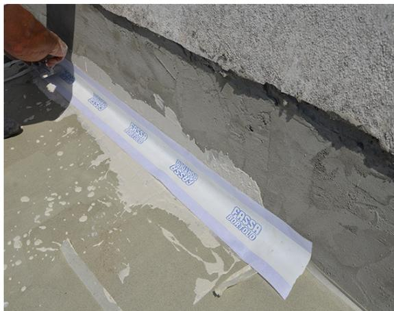
O sistema impermeável AQUAZIP ONE também será aplicado nas faces verticais e, após uma maturação adequada, será revestido com um repute de K17 ou KZ 35, rebocos à base de cal e cimento, para exteriores e interiores, aditivado com AG 15, dispersão de resinas sintéticas para produtos de base cimentícia. O reboco de base deverá ser terminado com talocha fina, prevendo a interposição, na fase de posa, de uma rede sintética porta-reboco de malha larga.
